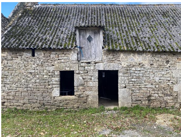
Exemple d'architecture en granite, maison, façade sud, Brangournay, Saint-Servant - © OLIGO Baptiste, Pays de Ploërmel
