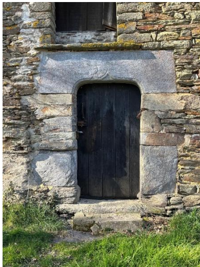
Exemple d'un linteau de porte d'entrée en schiste bleu, maison, façade sud, Lézalain, Carentoir - © PRINCELLE Chantal, Mairie de Carentoir
